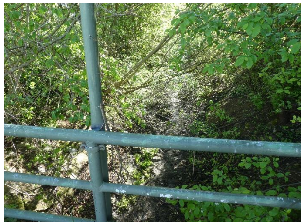
Abb. 9: Im Frühjahr trockener Graben, der aus einer Verdolung „entspringt“
